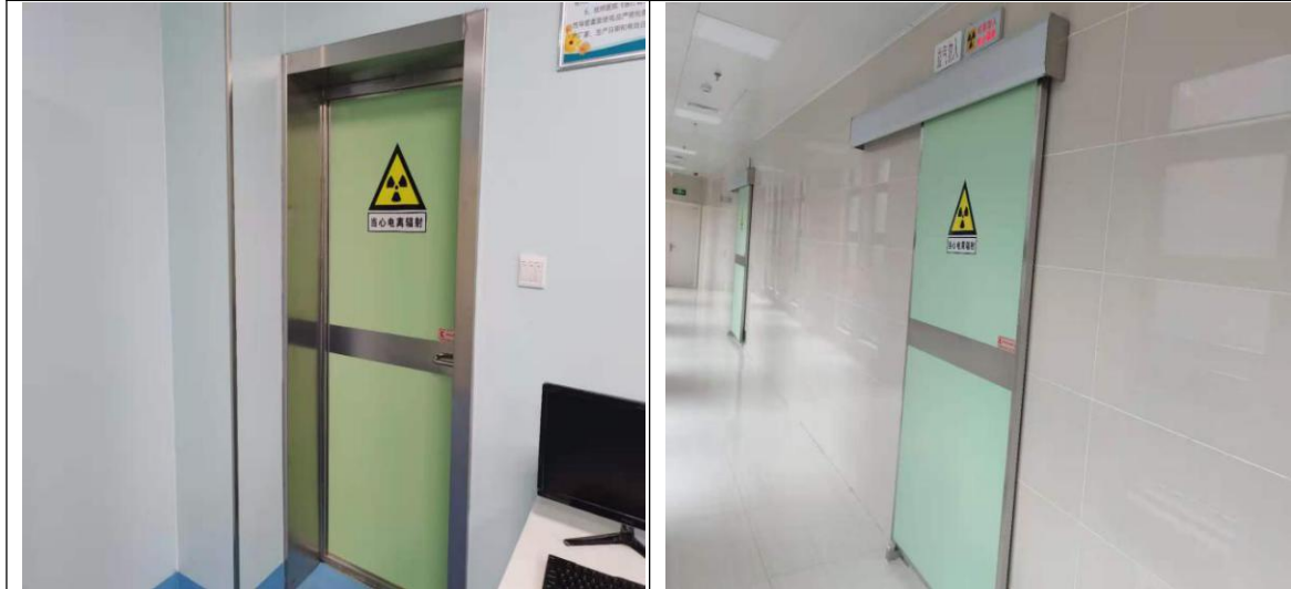
机房东侧医生通道门
