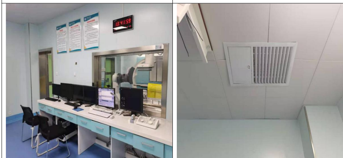
机房东侧控制室
