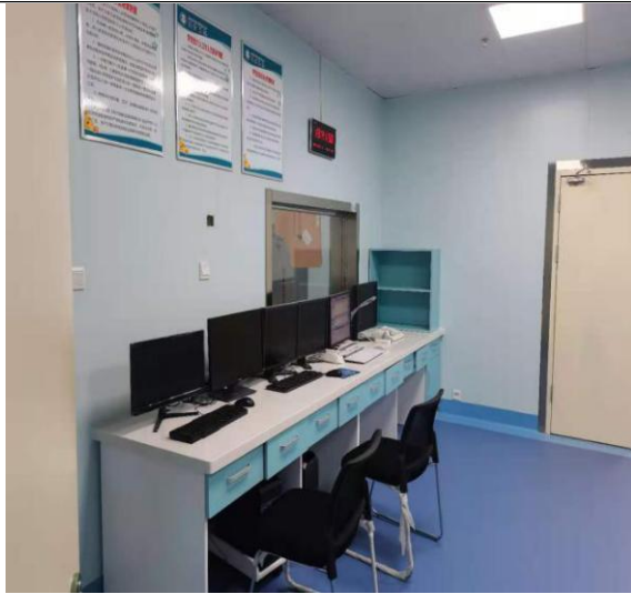
控制室旁设备间
